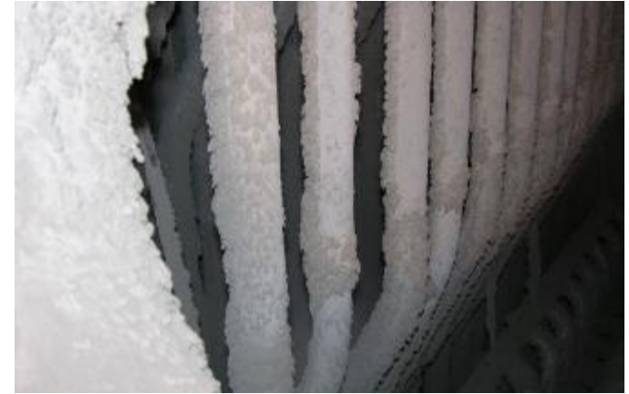
伝熱管表面におけるファウリングの様子
